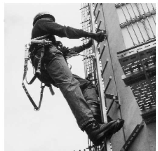
Der Monteur ist mit einem Haltegurt an einer Steigschutzvorrichtung gesichert.
