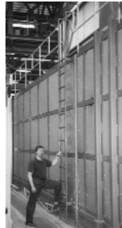
Ortsfeste Leiter, die nur selten begangen werden muss, z. B. für Instandhaltungsarbeiten.
