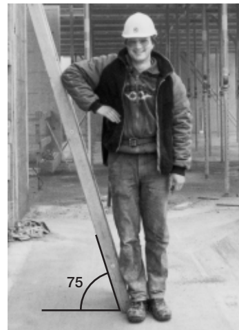
Die richtige Neigung der Leiter lässt sich mit der Ellbogenprobe bestimmen.
