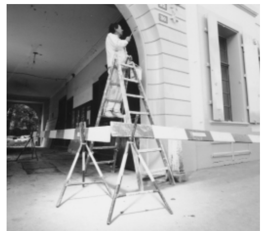
Gesicherter Standort im Verkehrsbereich.
