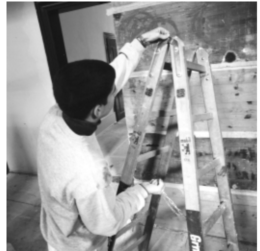
Intakte Leitern sind Voraussetzung für sicheres Arbeiten.
