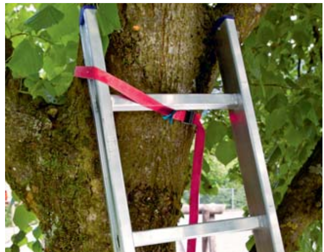
Bild 28: Gesichert mit Spanngurten
