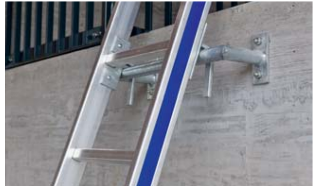
Bild 27: Einhängvorrichtung
