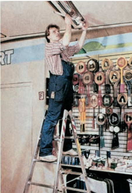
Bild 44: Sicherer Stand bei Über-Kopf-Arbeiten
