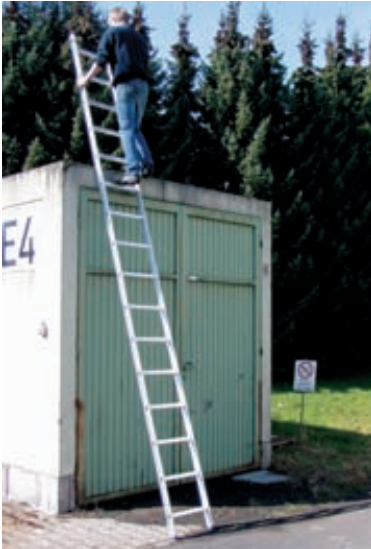
Bild 40: Übersteigen von der Anlegeleiter
